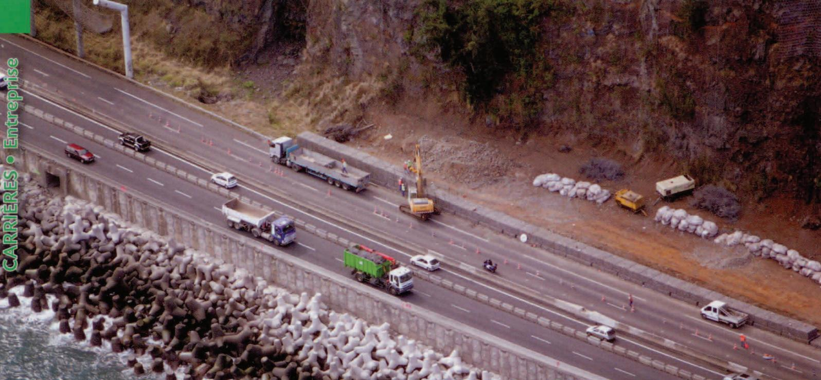
La société LTP Gabions+ en partenariat avec Aquaterra Solutions a réalisé un chantier de 55 000 m<sup>3</sup> de gabions préfabriqués à La Réunion.
