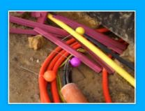
Dans le cadre des nouvelles réglementations liées à l'enfouissement des réseaux enterrés, de plus en plus de boules marqueuses seront posées lors de la réalisation de travaux souterrains notamment sur les réseaux électriques et gaziers.
