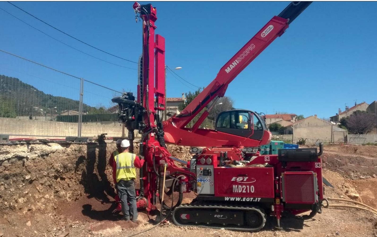
Perforatrice polifunzionale certificata CE versatile e con elevate doti di manovrabilità, utilizza le più avanzate tecnologie meccaniche ponendole al servizio della perforazione nell'ambito dell'ingegneria civile. Le perforatrici Class2 sono di tipo brandeggiabile e progettate per eseguire operazioni di perforazione verticale, sub-verticale e radiale.
