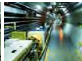
A magnet in the LEP (Large Electron Positron) collider tunnel. Un magnete nel tunnel del collisionatore LEP Large Electron Positron. Courtesy/Fonte: CERN
