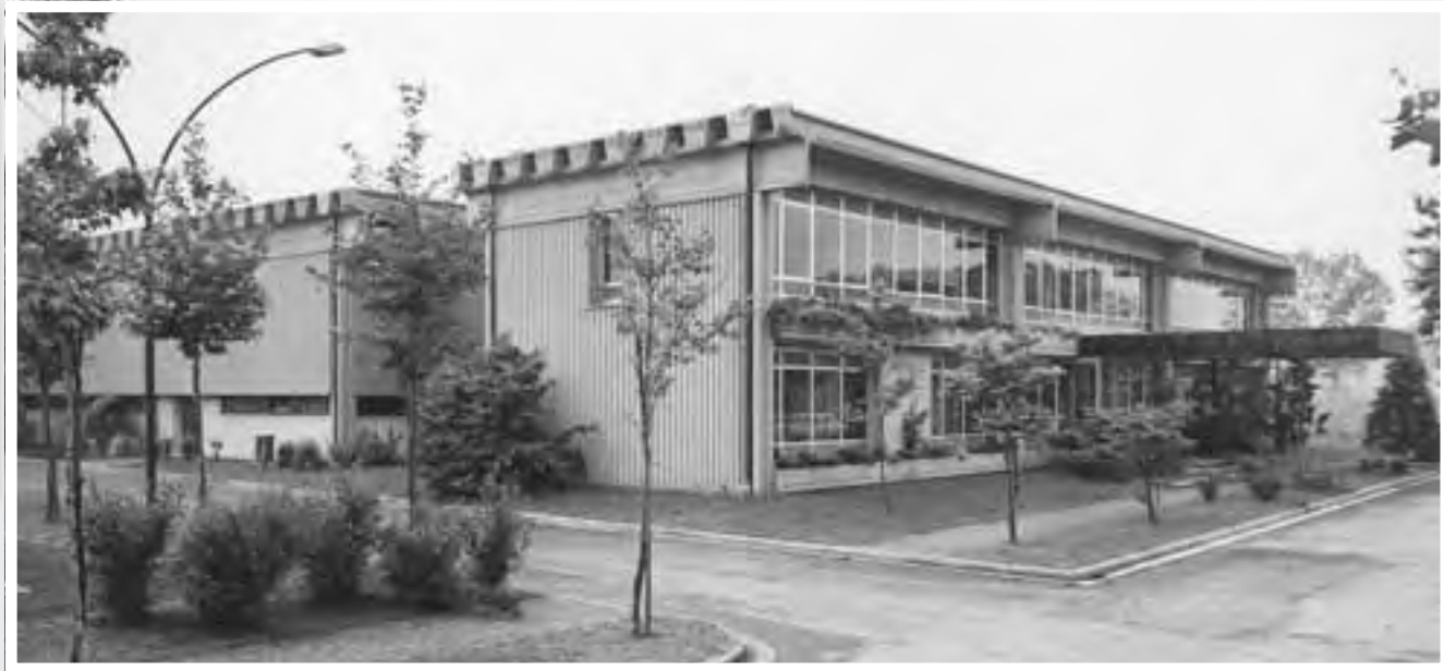
Top right: A phase of the construction of the building, in 1966-67. A destra in alto: Una fase della costruzione dello stabilimento, nel 1966-67.
