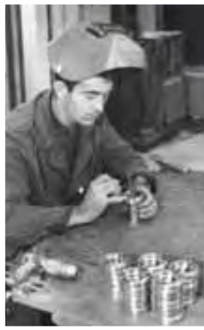
Assembling phase of HV/UHV Systems in the Torino plant. Fase di assemblaggio di Sistemi per Alto e Ultra-Alto Vuoto nello stabilimento di Torino.
