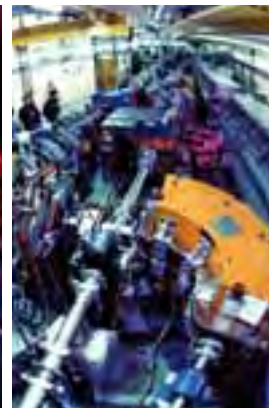
Transfer lines inside the PS (Proton Synchrotron) accelerator tunnel. Una sezione del tunnel dell'acceleratore PS (Proton Synchrotron). Courtesy/Fonte: CERN
