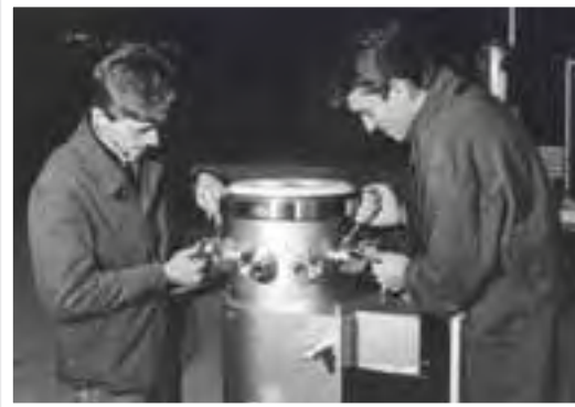
Assembling phases of HV/UHV Systems in the Torino plant. Fasi di assemblaggio di Sistemi per Alto e Ultra-Alto Vuoto nello stabilimento di Torino.
