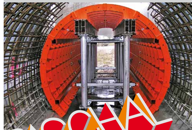
Tunnelschalwagen – Klappschalung mit GASS Unterstützung Tunnelsanierung F-Haudiomont, Fa. Berthold s.a., F-Dieue sur Meuse
