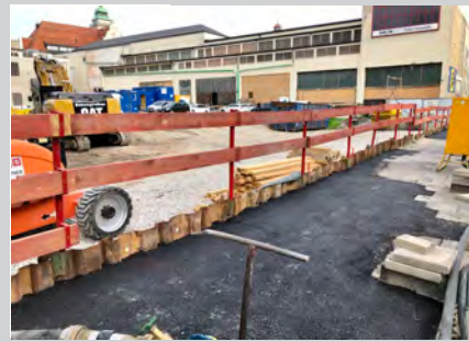
an der Spundwand
