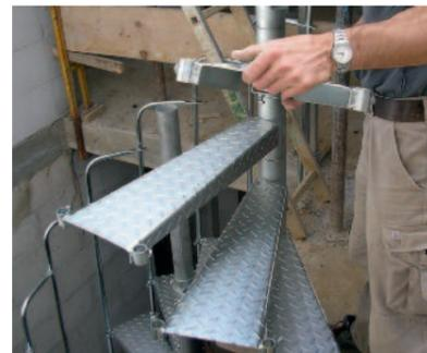
Stufen werden auf die Stufenhalter aufgesteckt
