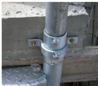
Rohrschellenbefestigung des Spindelrohrs ohne Distanzhalter
