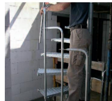
Geländerstäbe einfädeln und in Stufe stecken
