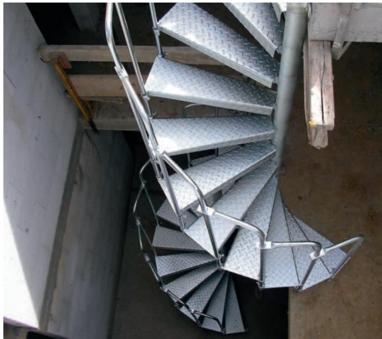
2 Geschoß Bautreppen fertig eingebaut von oben
