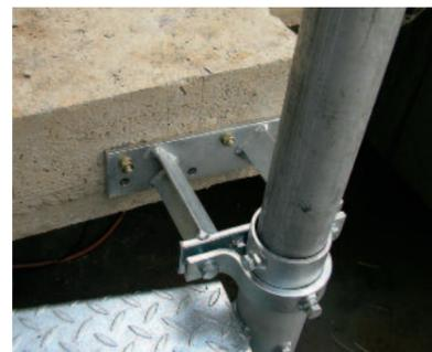
Spindelrohr mit Distanzhalter an der Deckenkante
