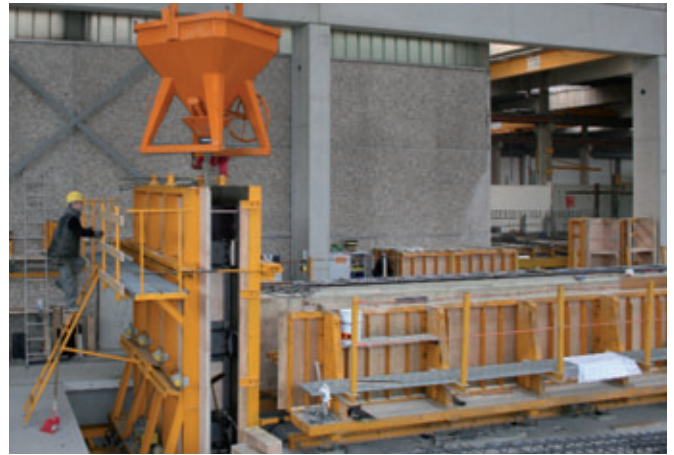
Die neue Fußfundamentschalung wurde vor die bestehende Zwillingschalung gesetzt
