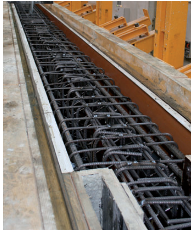
Bis zu einer Bauteilhöhe von 2,30 m können sowohl Parallel- als auch Satteldachbinder mit der neuen Binderschaling hergestellt werden
