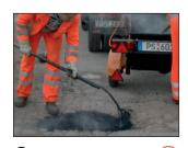
Das eingefüllte Mischgut wird mit einer Harke gleichmäßig verteilt.
