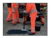
Das verfüllte Schlagloch wird mit einem Stampfer verdichtet. Bei größeren Stellen erfolgt dies mit einer Rüttelplatte oder einer Walze.
