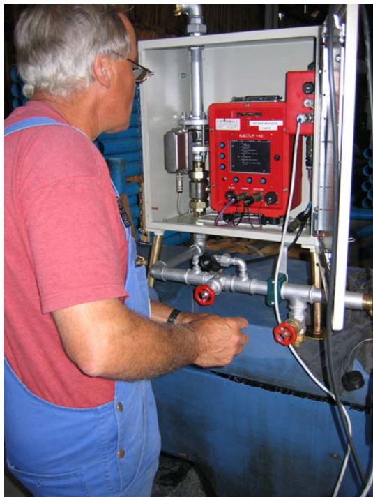
Druck-/Mengenmessgerät Injektlim 4G im Einsatz
