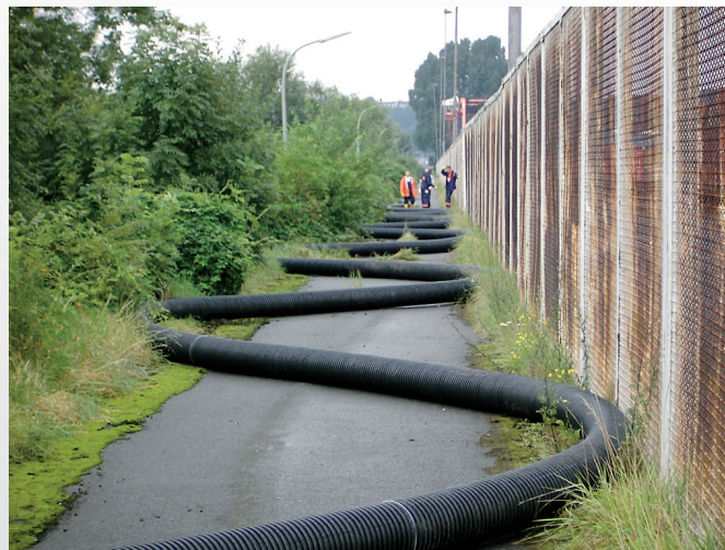
Einzug von 140 m Flexoren DN 270 in einem Arbeitsgang
