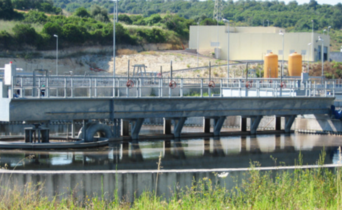
05-091 Ponte sedimentatore circolare aspirato a trazione periferica.
