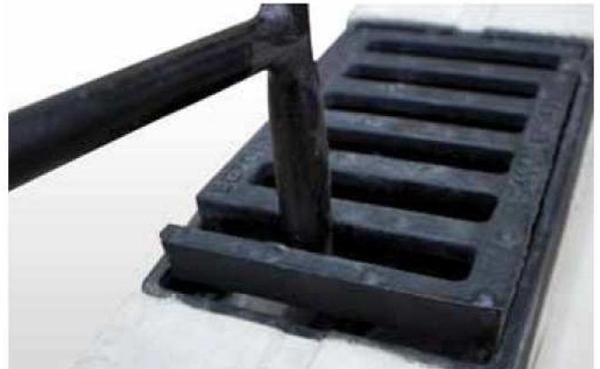
2. Aufhebeln des Rostes
