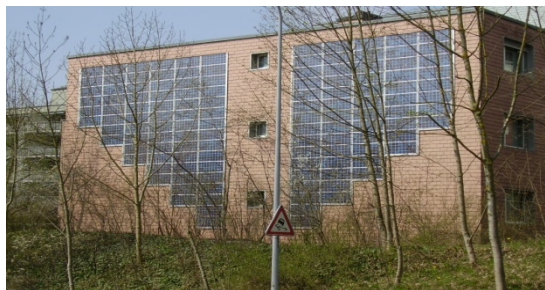
Façade : esthétique et énergie photovoltaïque
