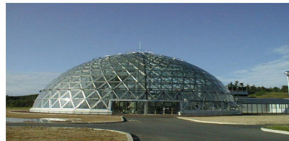
Dôme solaire photovoltaïque
