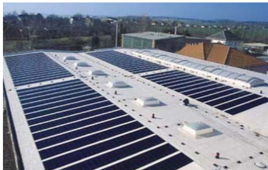
Toiture en membrane d'étanchéité
