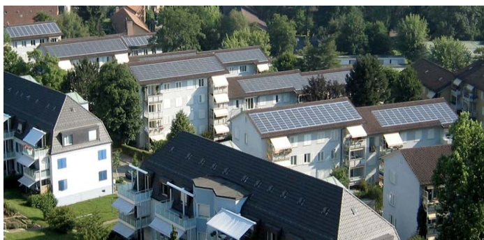
Collectif en toiture photovoltaïque
