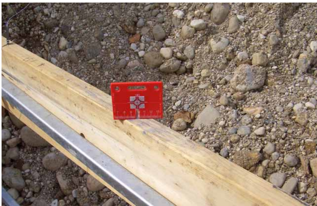
RS95 – Travaux de piquetage sur le gabarit d'implantation.
