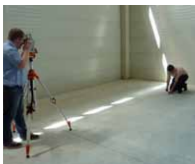
RS95 – Travaux de piquetage sur le gabarit d'implantation.
