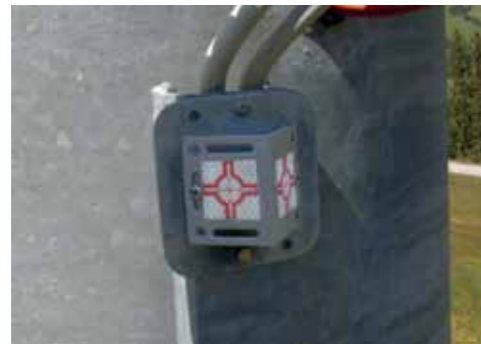
Repère sur pylône remonte-pente
