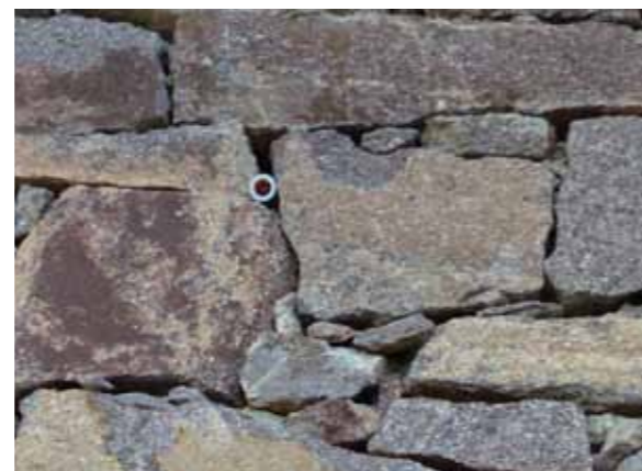
RSMP12 – Monitoring de la maçonnerie
