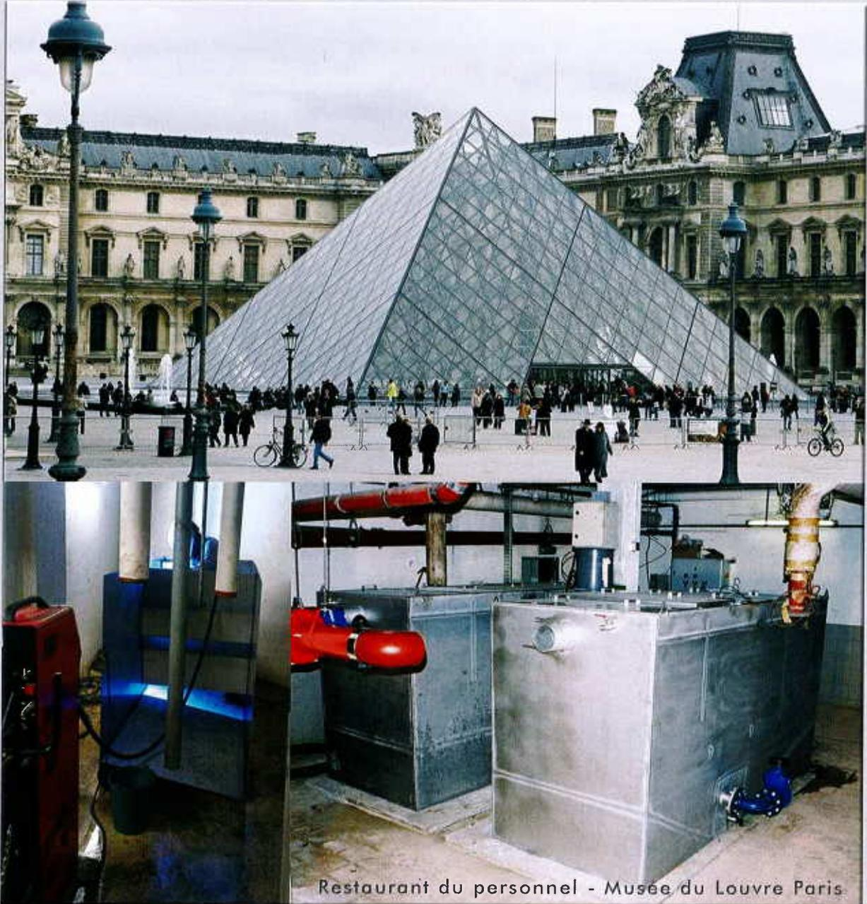
**Séparateurs à graisses en acier inoxydable avec débourbeur intégré conforme à la norme DIN 4040.**
