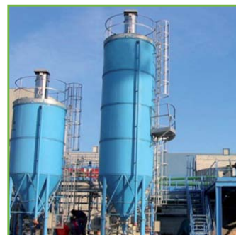
» FILTROS DE PURGA SILOS
