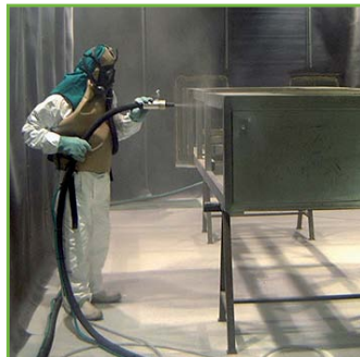
» TRATAMENTO COM JATO DE AREIA E DE GRANALHA
